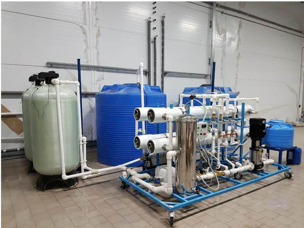
Рис. 1 – Система обратного осмоса в комплексе с предварительной водоочисткой
